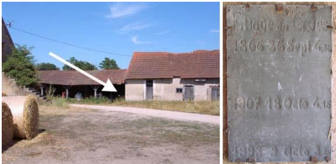
Figure 8 – Repère de crue sur les bâtiments de la ferme de la Motte-Veillot
